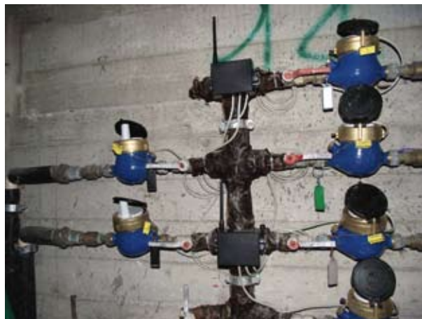
Fig. 2 - La proposta di Smart Metering per il monitoraggio delle reti idriche: a-il sistema MultiReader b-un'installazione in nicchia c-un'installazione su palo
